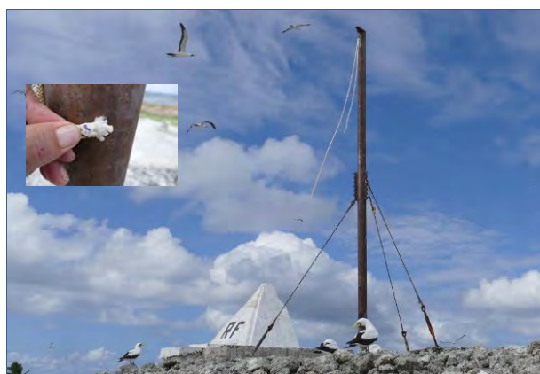
Fig. 35 - Absence de pavillon français pourtant installé en février 2016
